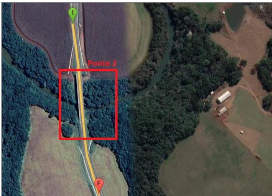
Figura 73: Trecho percorrido para o ensaio e localização da Ponte 2.
