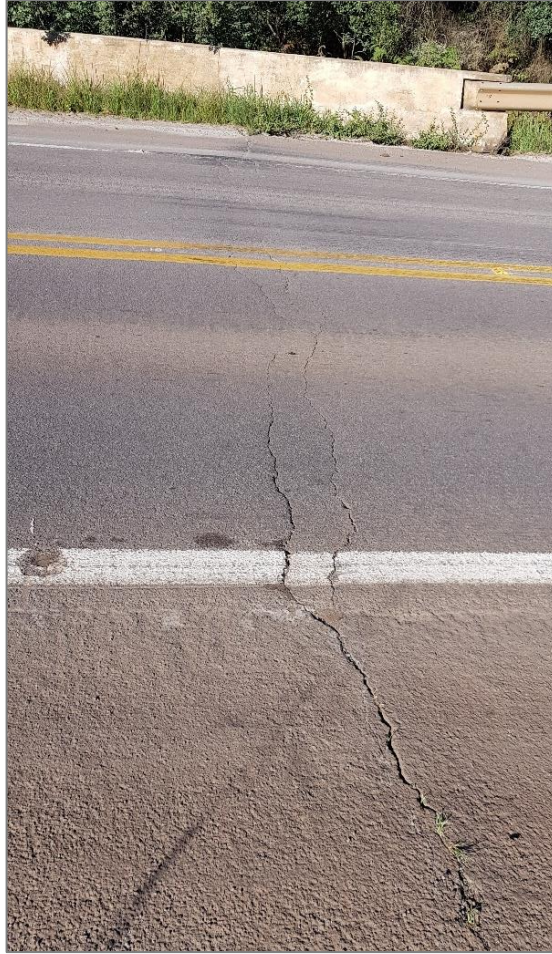
Figura 49: Condições de entrada da Ponte 1.
