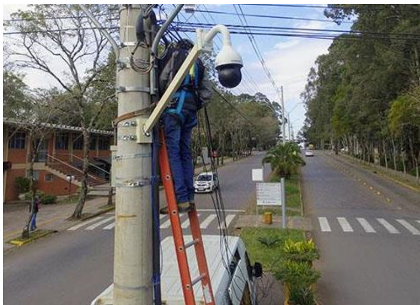
Figura 31. Câmera de alta resolução e capacidade de focar em 360 graus
