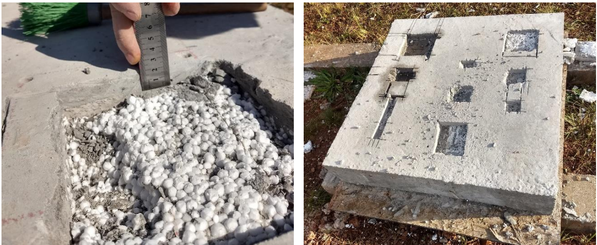
Figura 35- Ensaio de verificação de profundidade dos danos usando serra manual com disco de concreto
