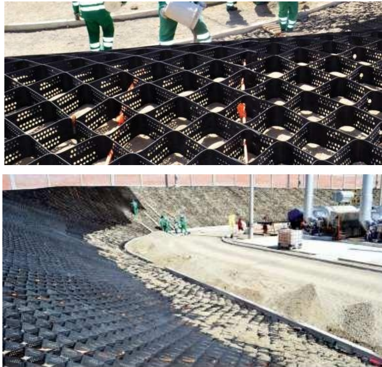
Figura 6: Controle de erosão com aplicação de geocélula
