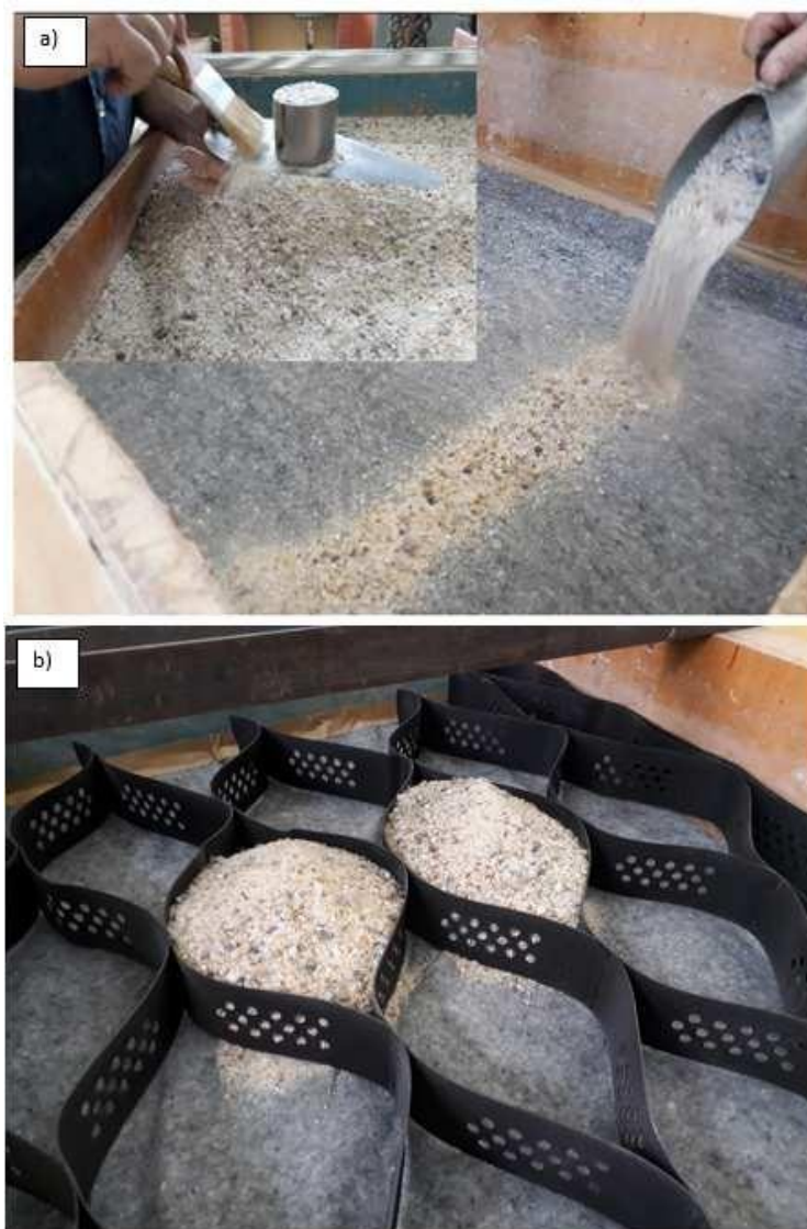
Figura 16: Preenchimento da camada de reforço.
