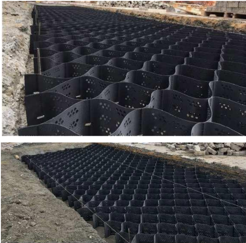
Figura 7: Reforço de subleito com uso de geocélula
