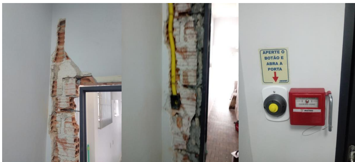
Figura 25: Detalhe de execução de um ponto elétrico
