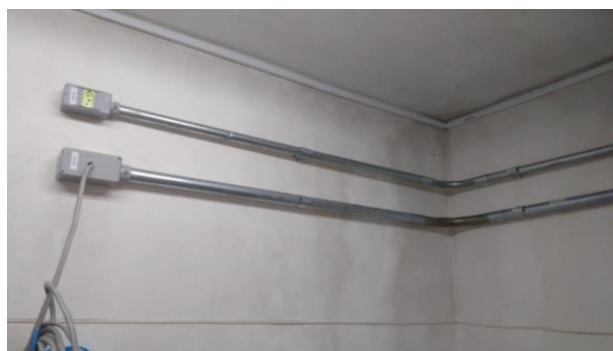
Figura 35: Execução de ponto elétrico com a infraestrutura sobreposta.
