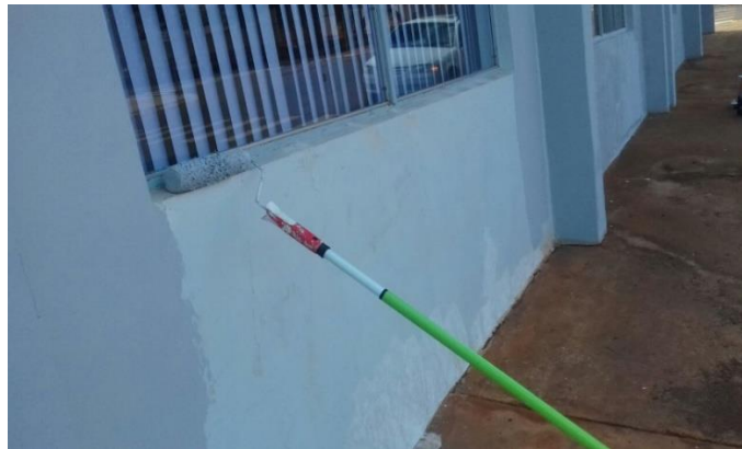
Figura 17: Execução de pintura acrílica sem emassamento
