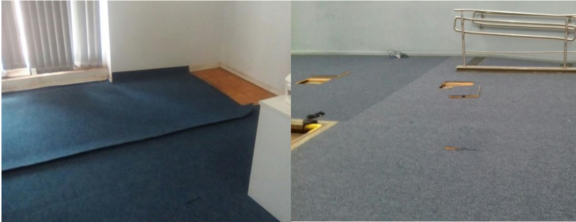
Figura 23: Piso carpete no processo de instalação
