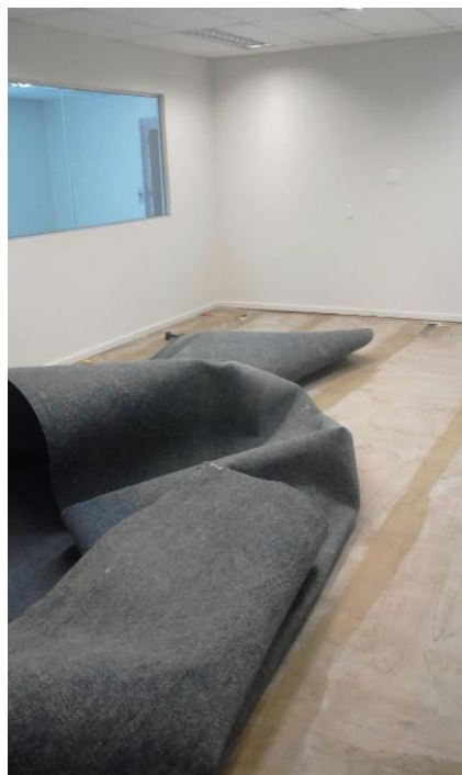
Figura 22: Detalhe do piso carpete avariado que está sendo removido
