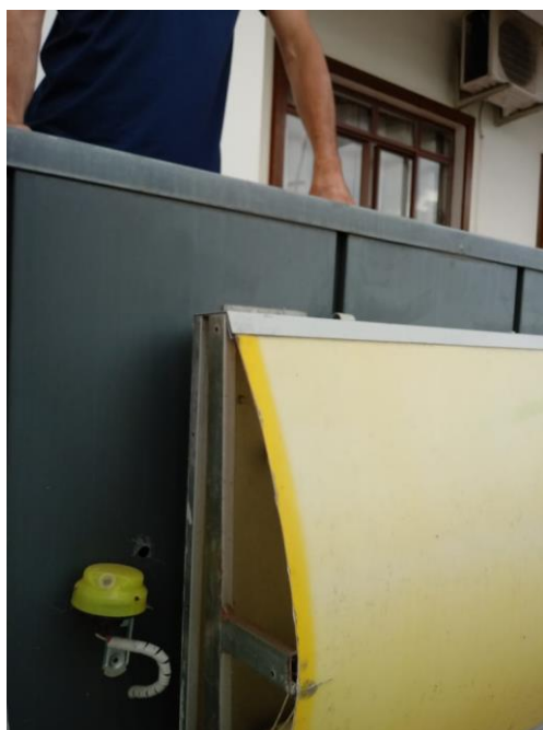
Figura 27: Detalhe da película adesiva apresentando desbotamento.
