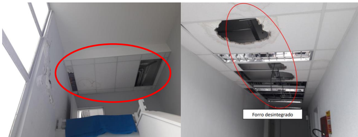
Figura 12: Detalhamento do forro de fibra mineral apresentado manchas e apodrecimento
