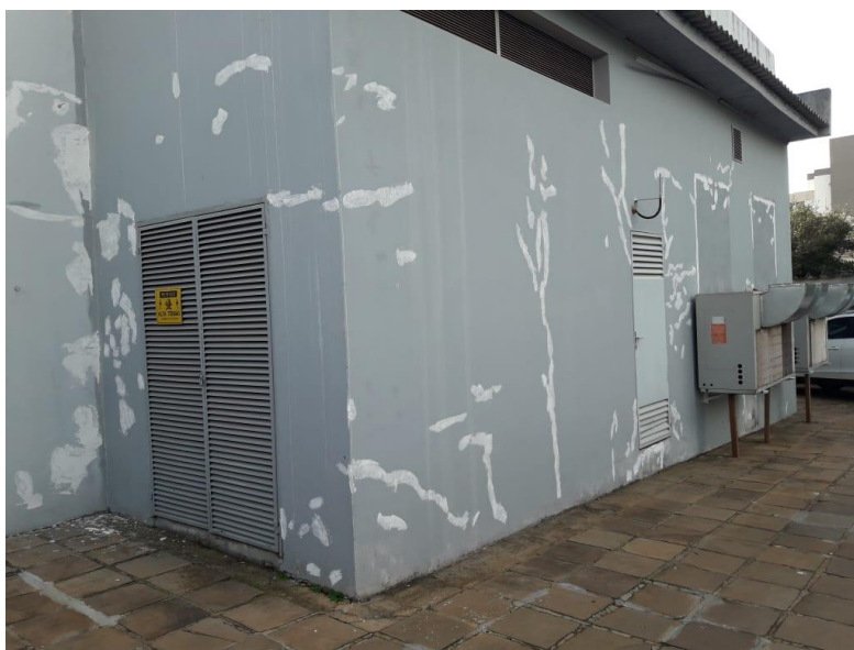
Figura 19: Detalhe de correções de avarias com massa acrílica
