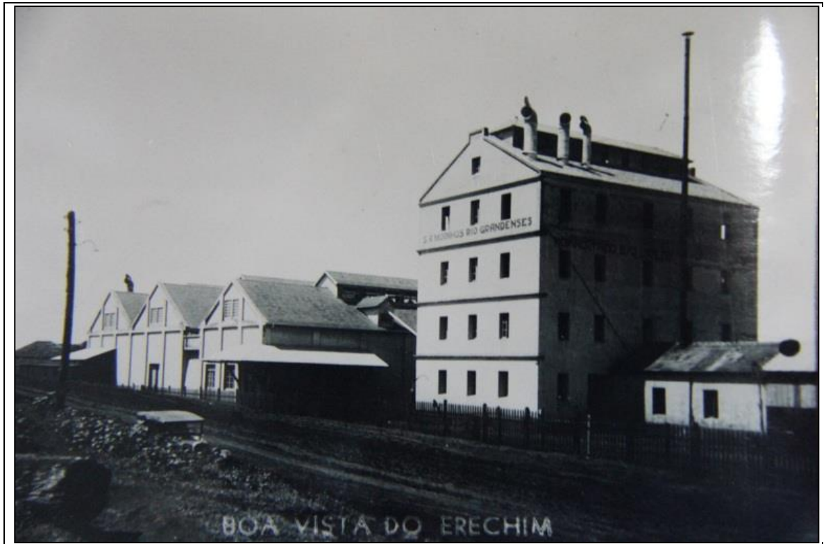
Figura 20- Antigas instalações do Moinho Riograndense
