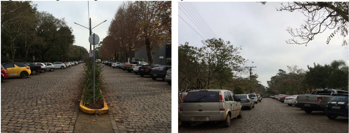
Figura 45 – Registro fotográfico das vias no campus I da UPF
