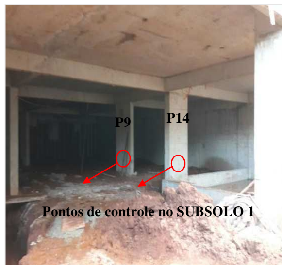
Figura 41 – Identificação dos pontos de controle no subsolo 1.
