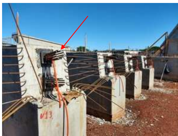
Figura 24 - Viga protendida para pontes Fonte: Produzido pelo autor (2019)
