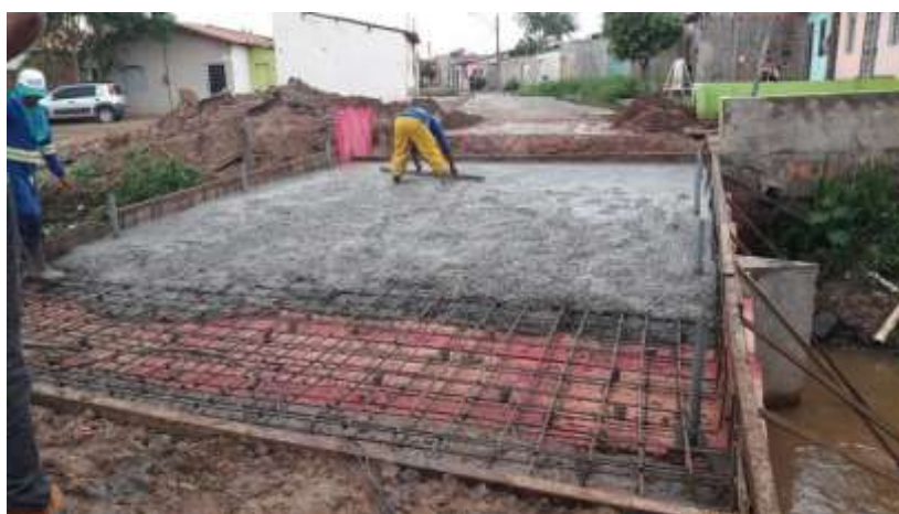
Figura 30 - Exemplo de uma ponte em laje moldada Fonte: Folha do Bico (2017)
