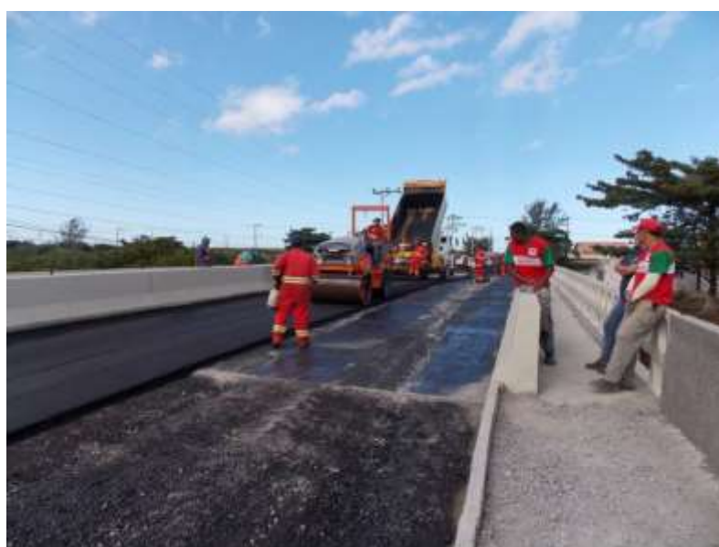
Figura 50 - Pavimentação em ponte Fonte: Renato (2017)
