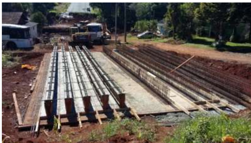
Figura 26 - Vigas pré-moldadas estocadas no canteiro de obras Fonte: Produzido pelo autor (2019)
