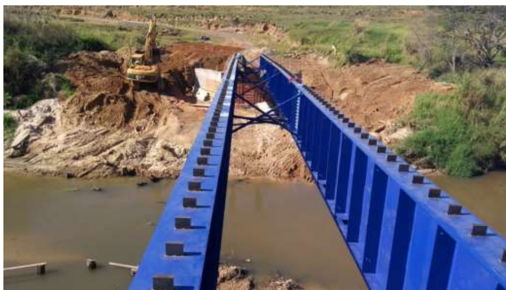
Figura 117 - Obra de ponte concreto e aço EcoMix, com 40 metros de comprimento, instalada no município de Presidente Bernardes, estado de São Paulo – Tipo P1 M(S) 2V
