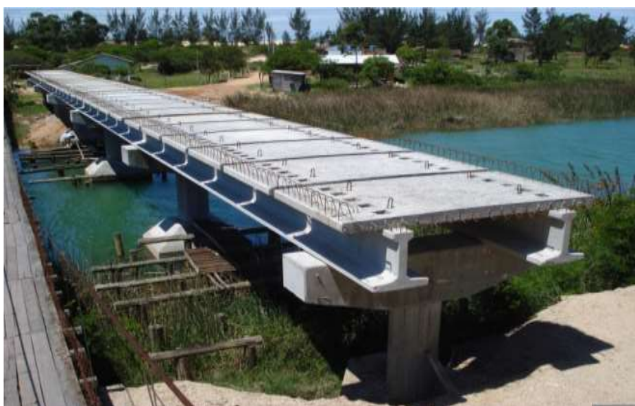
Figura 28 - Representação de laje pré-moldada Fonte: Protensul (2019)
