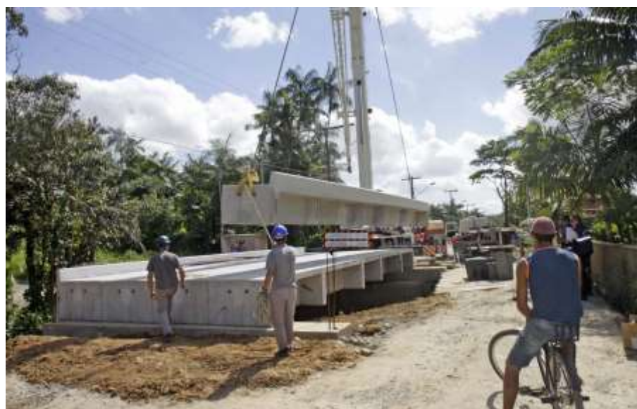
Figura 119 - Kit de transposição de obstáculo sobre o rio Motucas, na Estrada dos Portugueses, bairro Vila Nova, Joinville-SC - Tipo P23 PMD 5V Fonte: Prefeitura de Joinville (2019)
